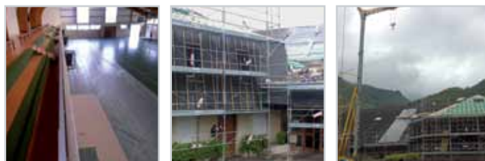
Rénovation du toit du gymnase
