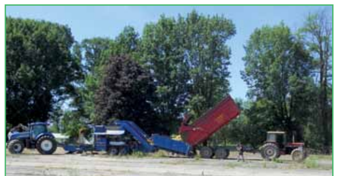
Le chantier d'enrubannage
