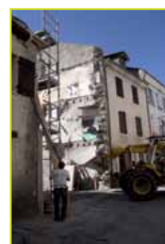
Rue du Bourguet : démolition de la maison Figué
