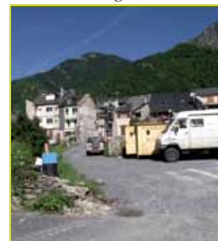
Démolition de la maison Figué Accès parking
