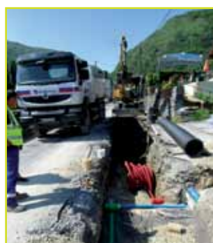
Travaux rue du Bourguet
